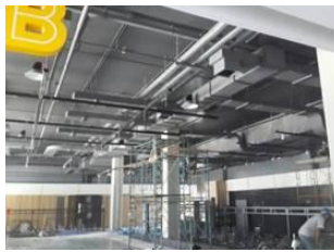
งานระบบท่อส่งลม ปรับอากาศ/ระบายอากาศ
