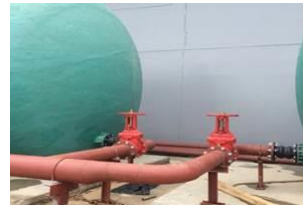
งานติดตั้งท่อสูบล ระบบดับเพลิง
