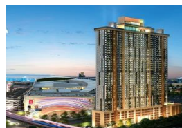
Plum condo central station เฟส 2 Scope of Works: ระบบไฟฟ้า, ระบบสุขาภิบาล, ระบบปรับอากาศ, ระบบดับเพลิง
