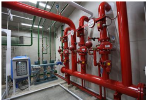
งานระบบท่อดับเพลิงและ ควบคุม
